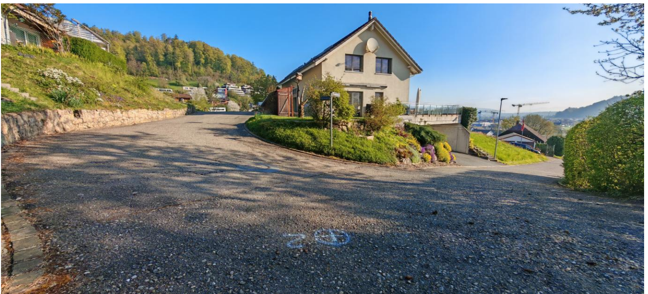
Abb. Nr. 2: Foto bestehender Zustand Binzenweg
